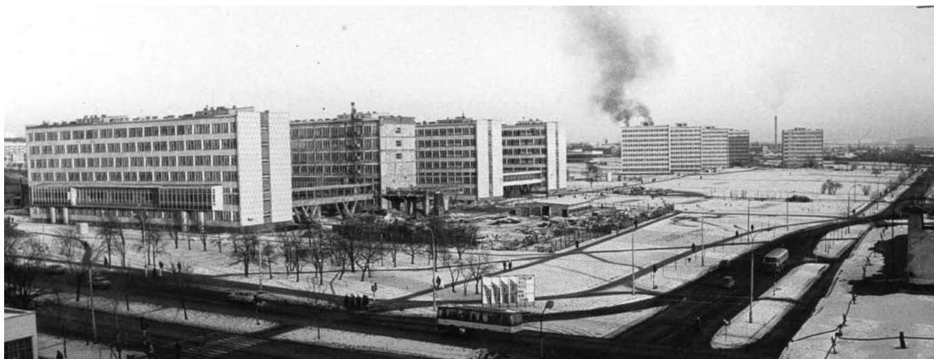
Rok 1984 – dobiega końca budowa kampusu Politechniki Świętokrzyskiej
