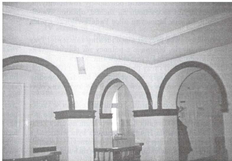
Ściana arkadowa na głównej klatce schodowej
