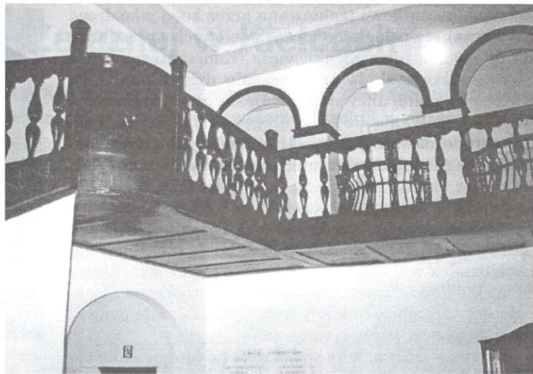
Fragment drewnianej balustrady schodowej na głównej klatce schodowej
