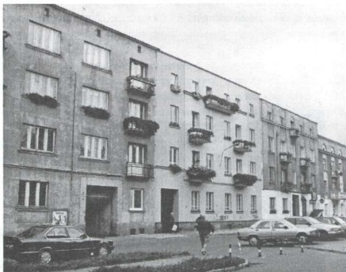
Dom przy ul. Czerwonego Krzyża w Kielcach, w którym również mieszkał prof. B. Pniewski i gdzie odbywały się także zajęcia tajnego Wydziału Architektury w 1944 r.
