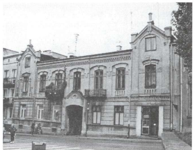
Dom przy ul. Wesolej 25 (dom Suligów) gdzie odbywały się zajęcia tajnego Wydziału Architektury w Kielcach w 1944 r.
