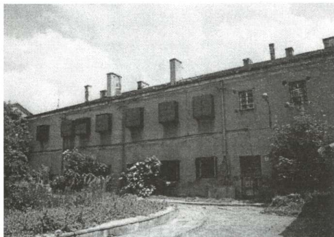
Fot. 3. Aktualny widok głównego budynku więziennego od strony dziedzińca wewnętrznego
