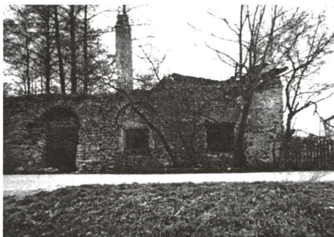
Widok ogólny ruin młyna wodnego w Słopcu k. Kielc
