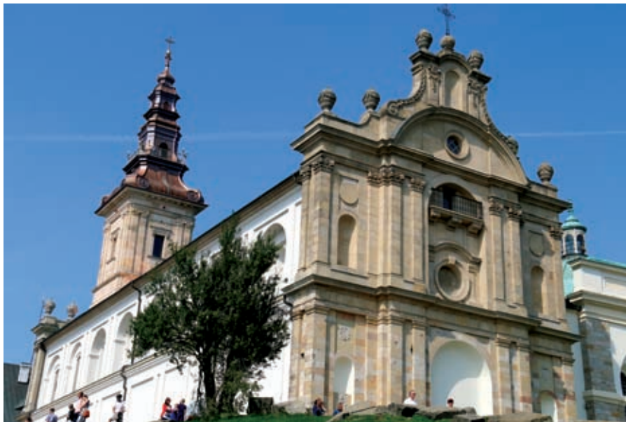
Wieża kościoła wróciła na swoje miejsce po 100 latach
